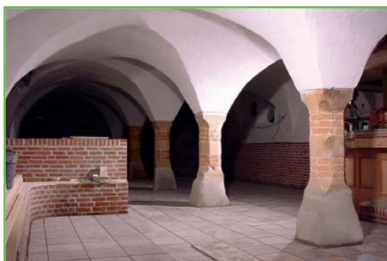
Näiden rakennusten sisäseinät entisöitiin KÖSTER Rappauslaasti 2 Valkoisella.
