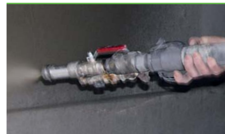
KÖSTER NB 1 voidaan asentaa harjaamalla tai ruiskuttamalla käyttäen esim. KÖSTER Peristaltic Pumpua.
