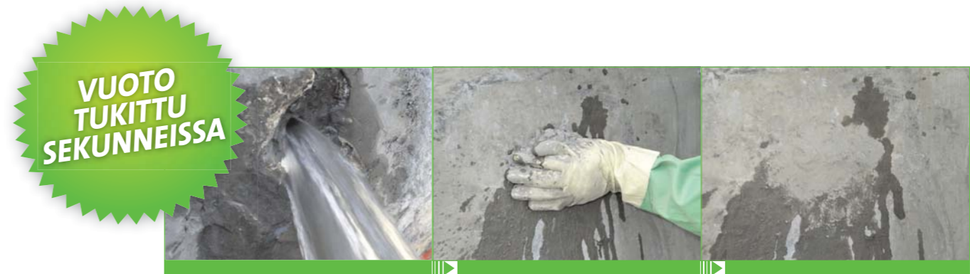
Aktiivinen vuotokohta on tiivis heti KÖSTER KD 2 Pikapulverin käytön jälkeen.
