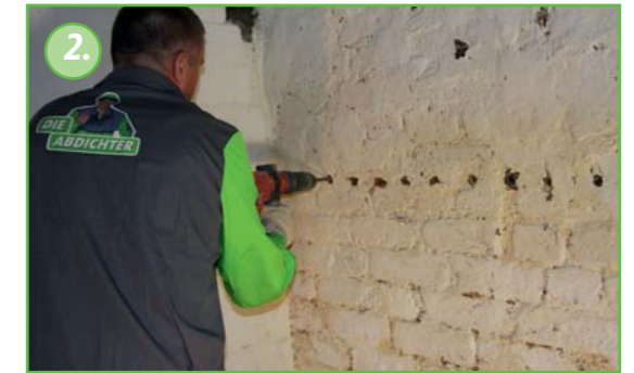
Porausreiät porataan sisäseiniin 10 cm välein toisistaan (seinäpaksuus 45 cm) aina syvyyteen 40 cm.
