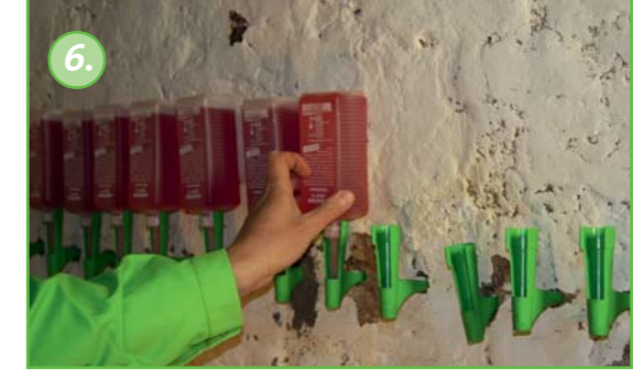
KÖSTER Crisin 76 Concentrate patruunat asennetaan imumutkiin.
