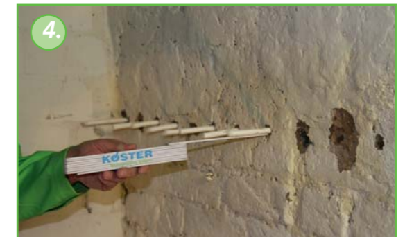
KÖSTER Kapillaaritangot asennetaan niin, että ne jäävät esiin 7 cm porausreikästä.
