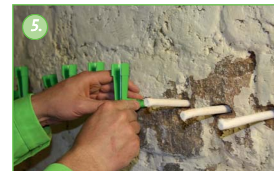
KÖSTER Imumutkat asennetaan niin, että KÖSTER Kapillaaritanko yltää KÖSTER Imumutkan syöttöpesään.
