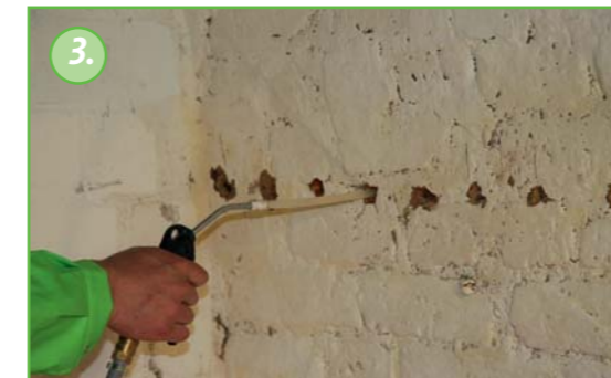
Porausreiät puhdistetaan pölystä puhaltamalla pöly ulos porausreikästä paineilmalla.
