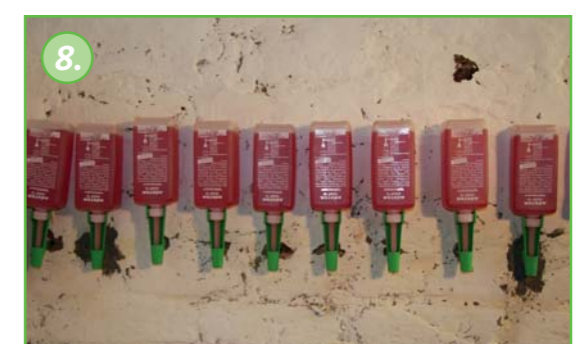
Paineeton KÖSTER Crisin 76 Concentrate injektointi muuraukseen alkaa välittömästi patruunoiden asentamisen jälkeen.
