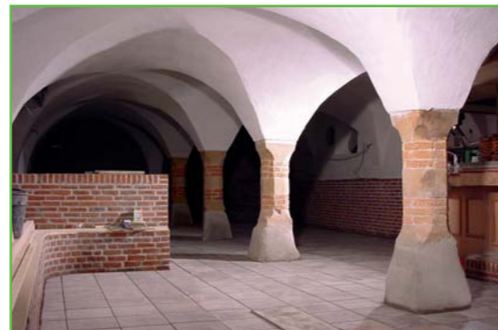
Sisäpuolen seinät näissä rakennuksissa on kunnostettu KÖSTER Rappauslaasti 2 Valkoisella.
