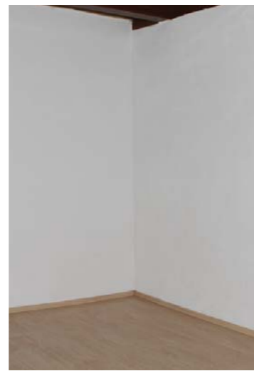
Kun KÖSTER Hydrosilikaattilevyt on asetettu paikoilleen, voidaan pinta hioa sileäksi. Myöhemmin koko alue peitetään KÖSTER Hydrosilikaattiliima SK kerroksella, jonka paksuus on enintään 2 mm. Normaaleissa huone olosuhteissa ja kun ilma kiertää hyvin, pinta voidaan 24 tunnin kuluttua tapetoida tai maalata hengittäville materiaaleilla.
