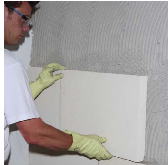
KÖSTER Hydrosilikaattiliima SK:ta levitetään levyn reunojen mukaisesti varmistaen että saumat on täysin kiinni.
