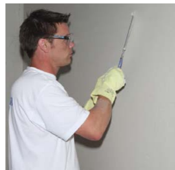
Kun KÖSTER Hydrosilikaattilevyt on asetettu paikoilleen, voidaan pinta hioa sileäksi. Myöhemmin koko alue peitetään KÖSTER Hydrosilikaattiliima SK kerroksella, jonka paksuus on enintään 2 mm. Normaaleissa huone olosuhteissa ja kun ilma kiertää hyvin, pinta voidaan 24 tunnin kuluttua tapetoida tai maalata hengittäville materiaaleilla.
