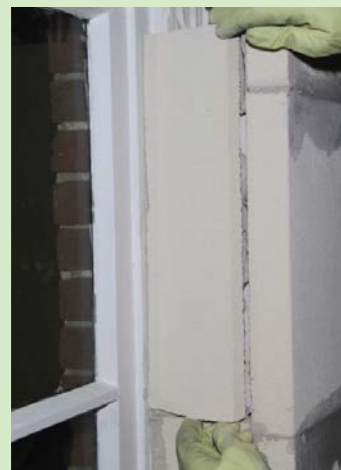
Yksityiskohtaisissa alueissa, kuten ovien ja ikkunoiden pielissä, joissa ei voida käyttää 50 mm paksuja levyjä, on saatavilla myös 25 mm paksuja levyjä.
