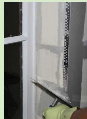
Ulkonurkat suojataan asentamalla kulmaprofiili.
