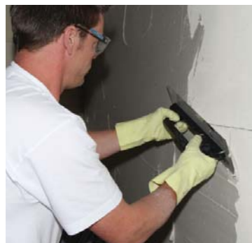
Kun KÖSTER Hydrosilikaattilevyt on asetettu paikoilleen, voidaan pinta hioa sileäksi. Myöhemmin koko alue peitetään KÖSTER Hydrosilikaattiliima SK kerroksella, jonka paksuus on enintään 2 mm. Normaaleissa huone olosuhteissa ja kun ilma kiertää hyvin, pinta voidaan 24 tunnin kuluttua tapetoida tai maalata hengittäville materiaaleilla.
