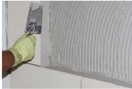
KÖSTER Hydrosilikaattiliima SK:ta levitetään levyn reunojen mukaisesti varmistaen että saumat on täysin kiinni.
