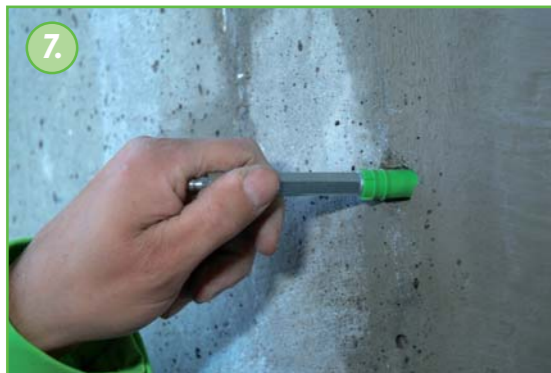
7. Asenna KÖSTER mansetit porausreikiin jättäen noin joka kolmas porausreikä avonaiseksi.
