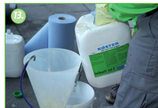
13. Puhdista pumppu KÖSTER PUR Cleanerin avulla kuten pumpun käyttöohjeessa on suositeltu.
