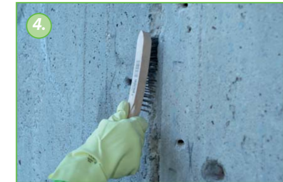
4. Putsaa halkeama käyttäen teräsharjaa.
