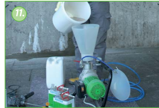
11. Valmistelee KÖSTER pumppu injektointityötä varten kuten ohjekirjassa on suositeltu. Täytä sekoitettu hartsipumppun materiaalisäiliöön. Valmiiksi sekoitettu materiaali tulee käyttää käyttöajan puitteissa.
