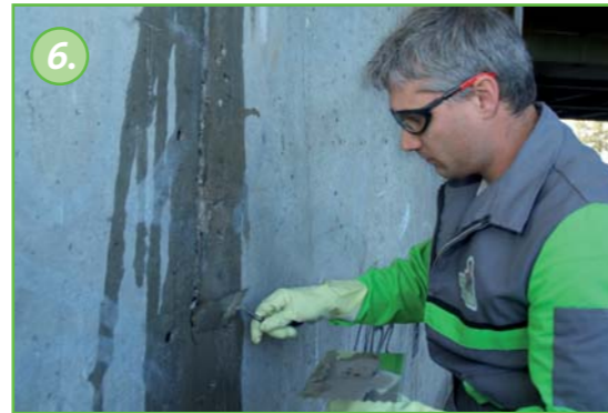
6. Sulje halkeama sen kulkusuunnassa KÖSTER KB-Fix 5 materiaalilla. Halkeaman sulkeminen ehkäisee injektointimateriaalin ennenaikaista valumista ulos halkeamasta injektoinnin aikana. Kovettumisaika on n. 5 minuuttia riippuen ympäröivästä lämpötilasta ja ilmankosteudesta.
