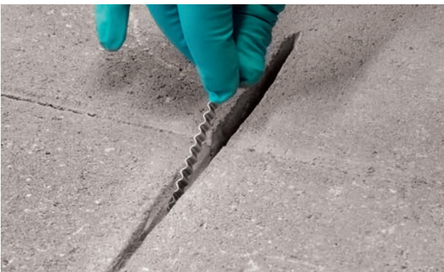
3. Aseta metalliset liitoshakaset halkeamaan
