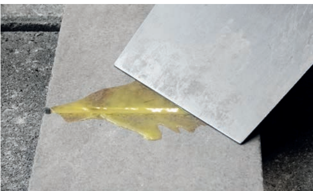
7. Tasoita/poista ylimääräinen pinta kevyesti lastalla
