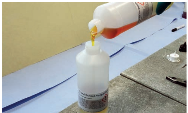
4. Sekoita hartsi ja kovete yhteen ja ravista
